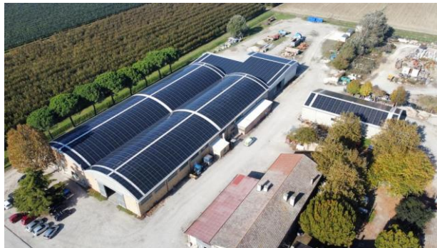
Impianto fotovoltaico da 808 kWp a Savarna
